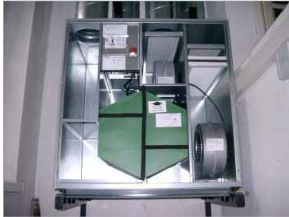
Lüftungsgerät – Innenansicht (Foto: Dr. Schulze Darup)
