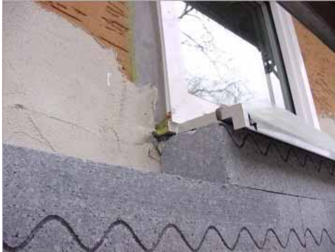
Luftdichter Fensteranschluss mittels 20 cm dickem WDVS (Foto: Dr. Schulze Darup)
