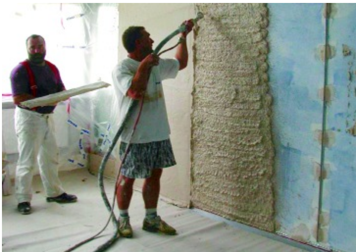
PCM-haltiger Gipsinnenputz wird an einer Wand aufgetragen (Foto: Fraunhofer ISE)
