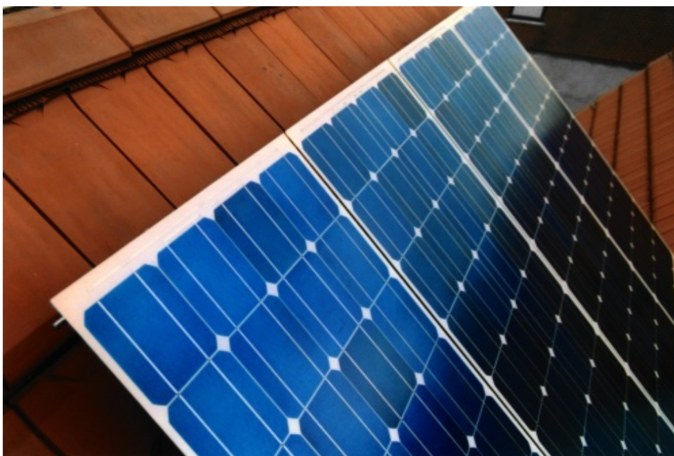
Solarmodule in Auf-Dach-Montage [Foto: BSi]
