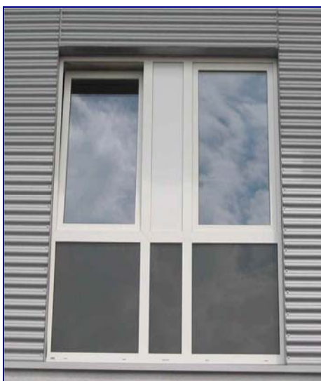
Die Fensterbrüstung im Feuerwehrhaus Gerbrunn enthält Vakuum-Isolations-Paneele (Foto: va-Q-tec AG)
