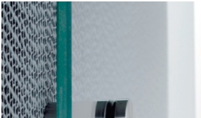
TWD-Fassade mit hinterlüfteter Verglasung (Quelle: gap-solar)
