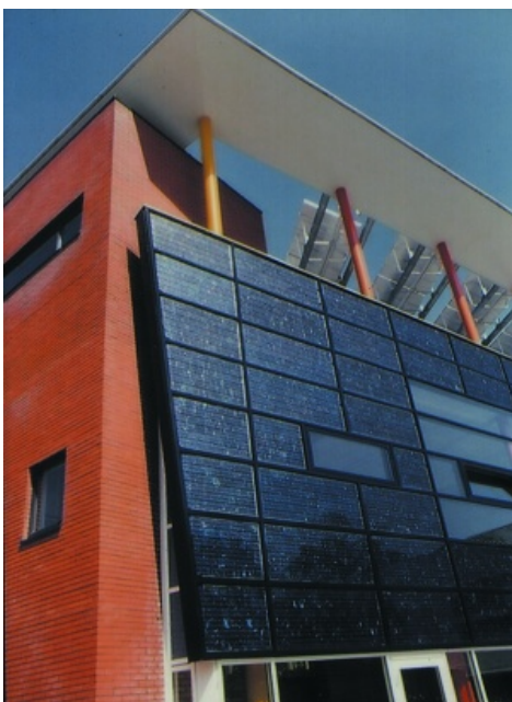
Links: Kaltfassade mit kristallinen Modulen am Rembrandt College in Veenendaal (Niederlande) [Quelle: Frauke Berger, DGS] Rechts: Gerahmte Photovoltaik-Standardmodule am Brüstungsbereich des Energieforums Berlin (Foto: Ralf Haselhuhn)
