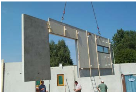
Betonfertigteil mit Vakuum-Isolation auf der Baustelle. Die Fassadenplatten werden später angebracht (Foto: Albert Hangleiter GmbH)
