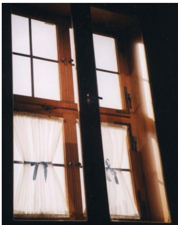
Kastenfenster im Denkmalschutz: Außen Einfachverglasung mit Sprossen, innen durchgehende Isolierglasscheibe.
