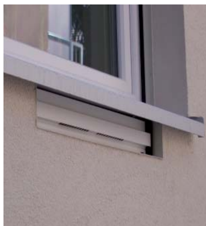
Zuluftelement einer Abluftanlage zum Einbau unterhalb der Fensterbank hinter dem Heizkörper
