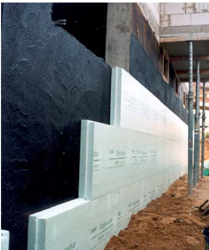
Dämmung auf der Wand eines Kellers, der zum beheizten Teil eines Gebäudes gehört.
