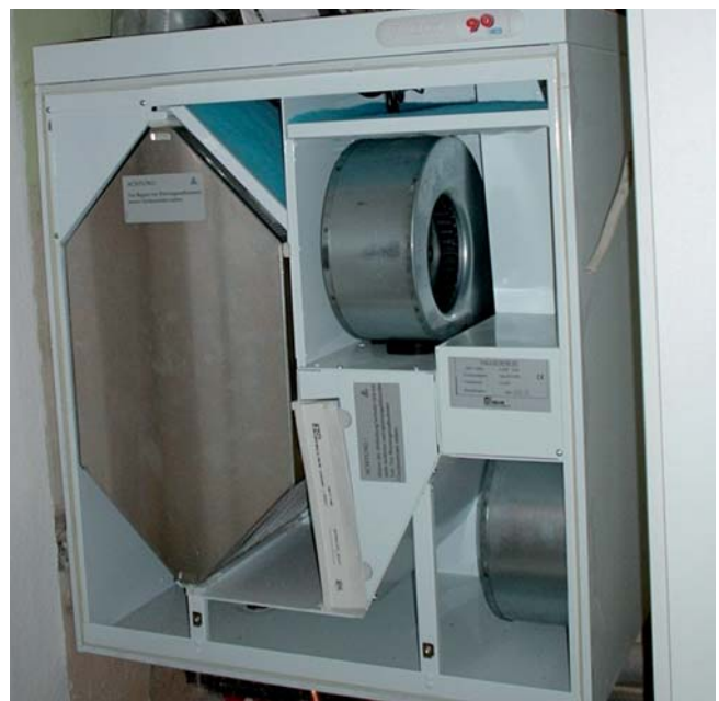
Ein Lüftungsgerät mit Wärmerückgewinnung; Abmessung ca. 80 x 80 x 50 cm
