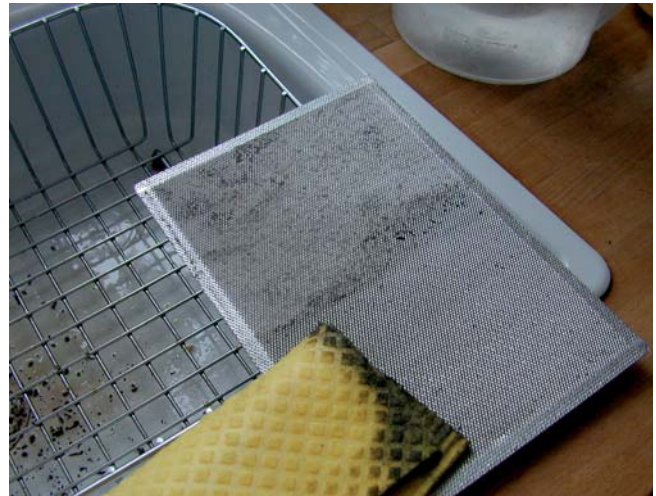
Der Filter eines Abluftventils aus Edelmetallgewebe wird mit Wasser und Spülmittel gesäubert.
