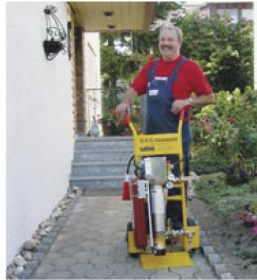
Wenn Stefan Fiedler, Mitarbeiter der Kiefer + Krämer Gebäudetechnik, zum Kesseltausch anrückt, bringt er gleich die mobile Elektroheizung mit.
