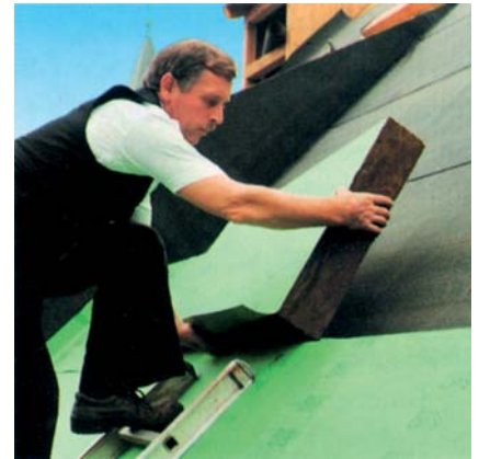
Dämmplatten aus Mineralfasern mit aufkaschierter Unterspannbahn
