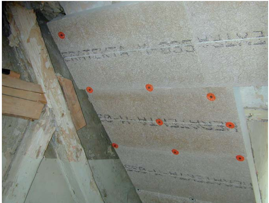
Die Hartschaumverbundplatten wurden unter den alten Innenputz der Dachschräge befestigt. Sie werden verputzt. Der Innenputz ist die notwendige luftdichtende Ebene, die Hartschaumplatten bilden die diffusionshemmende Schicht.
