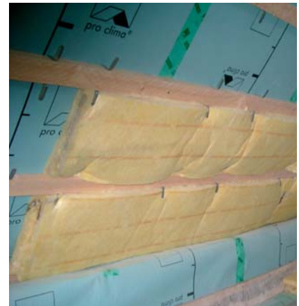
Untersparrendämmung 50 mm zwischen der Unterkonstruktion
