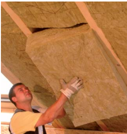
Dämmstoff sparrenhoch einbauen = 12-14 cm
