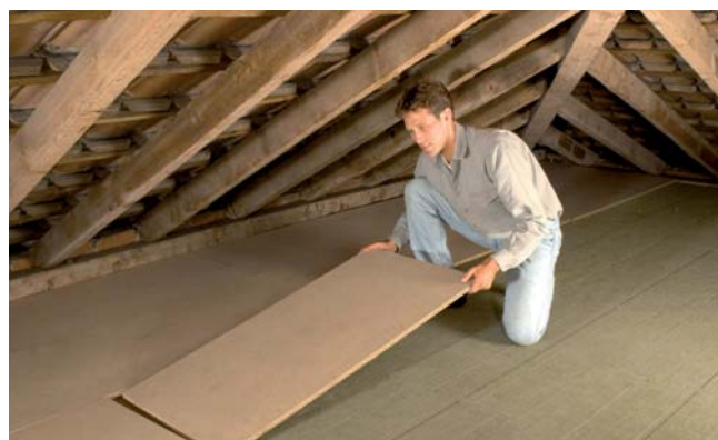
Wo häufiger auf Mineralfaserdämmplatten gelaufen wird, werden Hartfaserplatten o. ä. ausgelegt.
