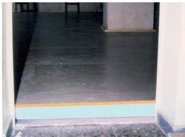
Hier wurde die nackte Betondecke eines Mehrfamilienhauses mit 12 cm Verbundplatten aus Polystyrol und Hartfaser gedämmt.
