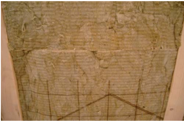
Dämmstoffe der Wärmeleitfähigkeitsstufe 035 bieten gute Dämmwirkung bei geringer Aufbauhöhe
