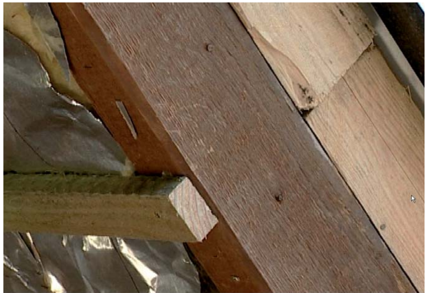
Der 12 cm starke Altsparren wurde hier 10 cm stark aufgedoppelt. Die Gesamtdämmstärke beträgt 22 cm. Zwischen die Lattung kam noch ein Untersparrenklemmfilz (2,4 cm) und raumseitig eine neue Luftdichtung bzw. diffusionshemmende Schicht, denn die Aluminium-Dampfsperre war 1960 sehr undicht eingebaut worden.
