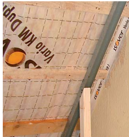
Luftdichtung unter den Sparren dicht einbauen
