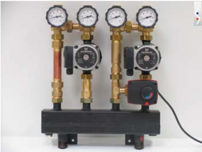
■ Bild 7: Sinus-HydroFixx mit geregeltm Heizkreis/ungeregelm Heizkreis.
