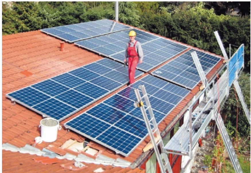
Sicherheit geht vor: Ob ein Leiterngerüst oder weiterer Aufwand für die Sicherung der Arbeiten nötig ist, muss im Angebot ersichtlich sein
