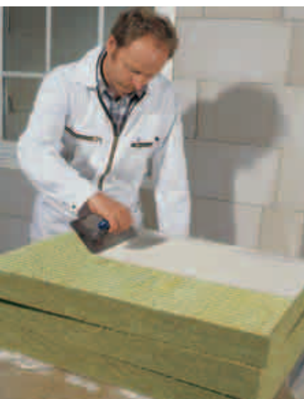
Der Auftrag des Klebemörtels erfolgt direkt auf die Platten.
