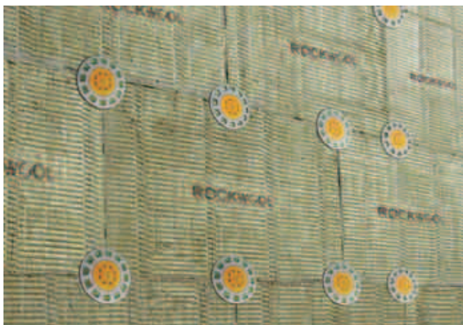
Durch die harte Außenseite der Coverrock werden die Platten bei der Verdübelung gleichmäßig und dicht an die Wand gedrückt.
