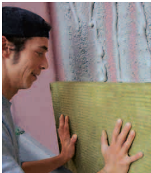
Die Dämmplatten werden dann direkt in das frische Mörtelbett gedrückt.
