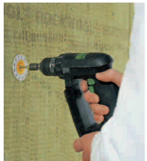
Die anschließende Verdübelung gibt der Platte sicheren Halt.
