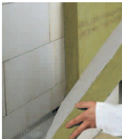
Danach werden die Platten auf das Mauerwerk geklebt.
