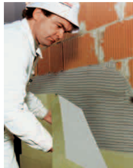
Die Lamellen werden danach in das frische Mörtelbett eingedrückt.
