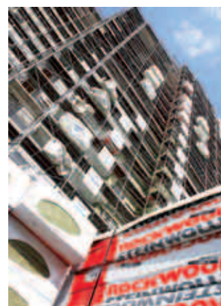
Fassadendämmung mit Rockwool: Sanieren lohnt sich dauerhaft.
