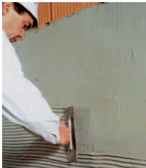
Anschließend wird der Putz idealerweise mit einer Zahnkartätsche durchgekämmt.
