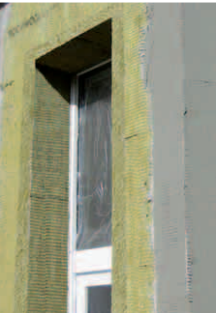
Fensterlaibungen werden mit der speziellen Laibungsplatte gedämmt.
