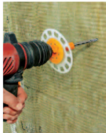
Die abschließende Verdübelung der Platten sorgt für sicheren Halt.
