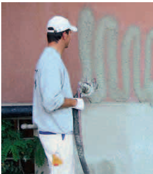
Der Auftrag des Klebemörtels erfolgt direkt auf das Mauerwerk.
