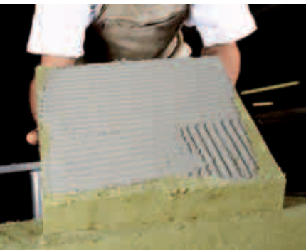
Auftrag des Klebemörtels auf die Platte.
