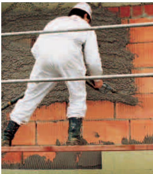
Der Auftrag des Klebemörtels kann maschinell erfolgen.
