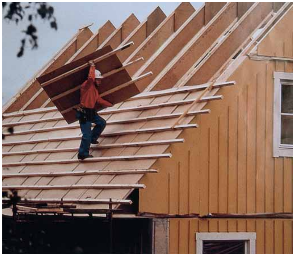
Abb. 1: Vor über 20 Jahren: Bau der NEH- Siedlung in Täby (Schweden) mit Masonite- Holzstegträgern. Quelle: [Lättbygg 1985]
