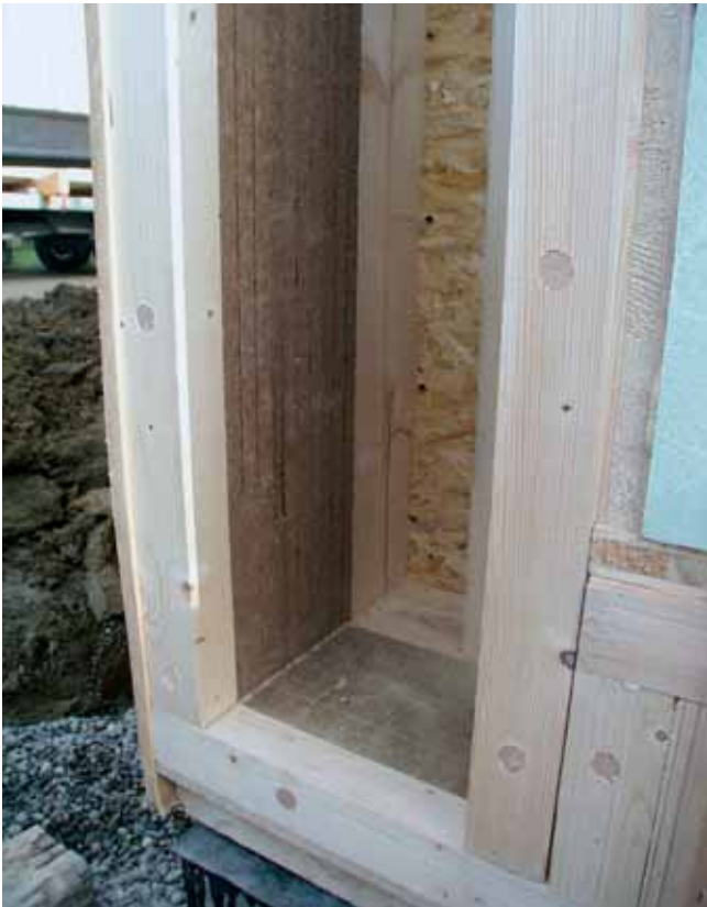
Abb. 3: PN Dämmständer und -sparren. Leimfrei verdübelt = wärmebrückenfrei entkoppelt. Foto: Fa. Kaufmann, Oberstadion
