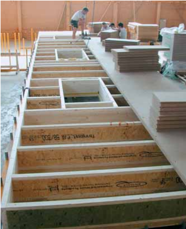
Abb. 2: Vorfertigung von Wandelementen mit Holzstegträgern. Foto: Fa. Finnforest, Bremen
