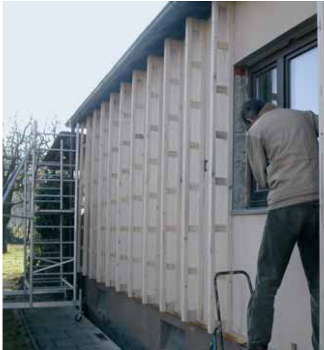
Abb. 4: Aufrustung einer Holzbauwand auf PH- Niveau durch vorgehangte U*psi Trager Typ F. Foto: Fa. Lignotrend AG, Weilheim
